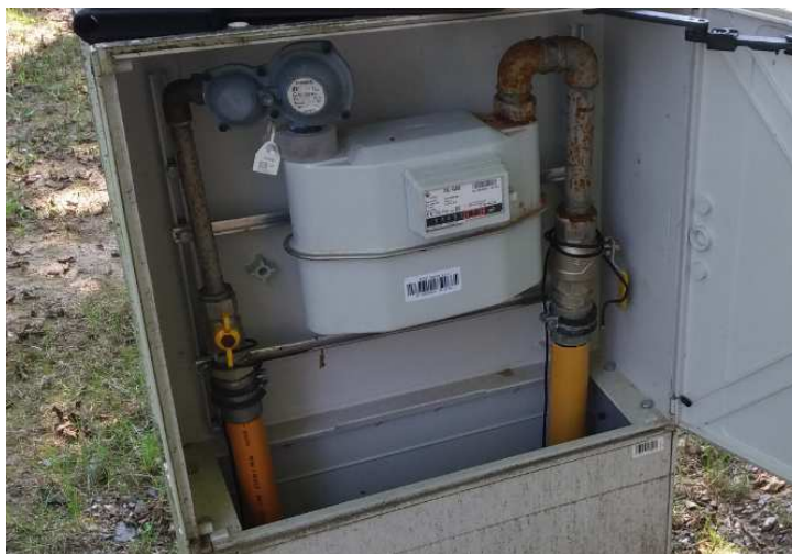
Obr. 2 – Stávající plynový pilířek s HUP, regulátorem tlaku B6 NG a plynoměrem BK-G4M
