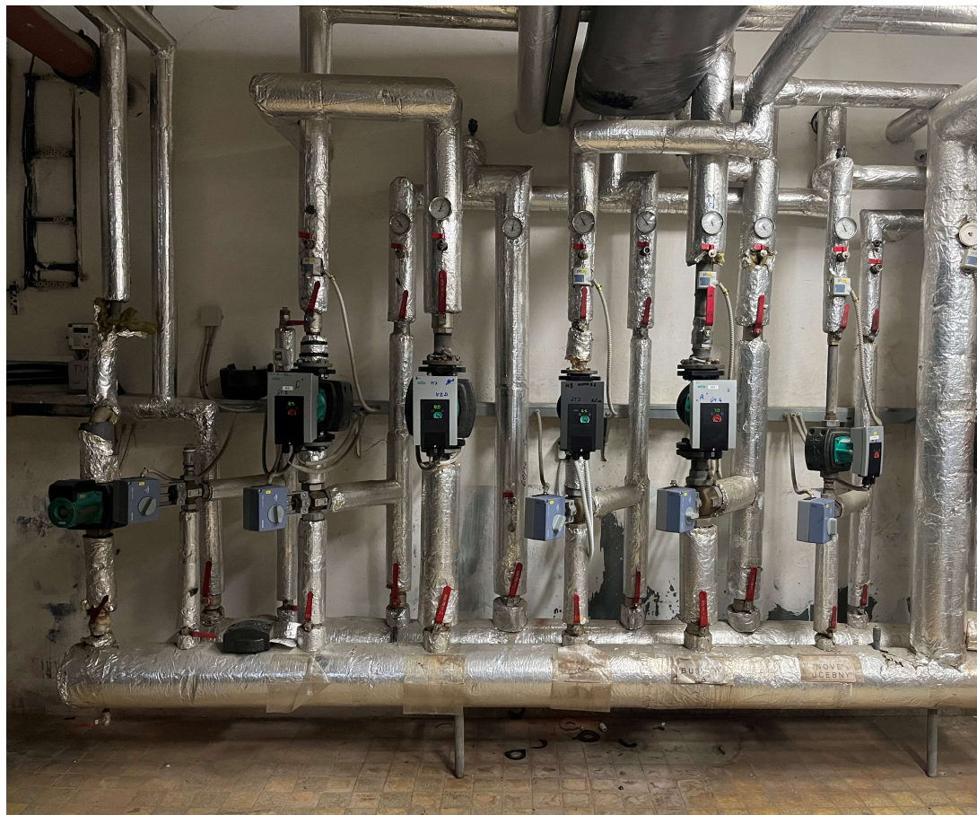
Obrázek 3 – Stávající trubkový rozdělovač, sběrač
