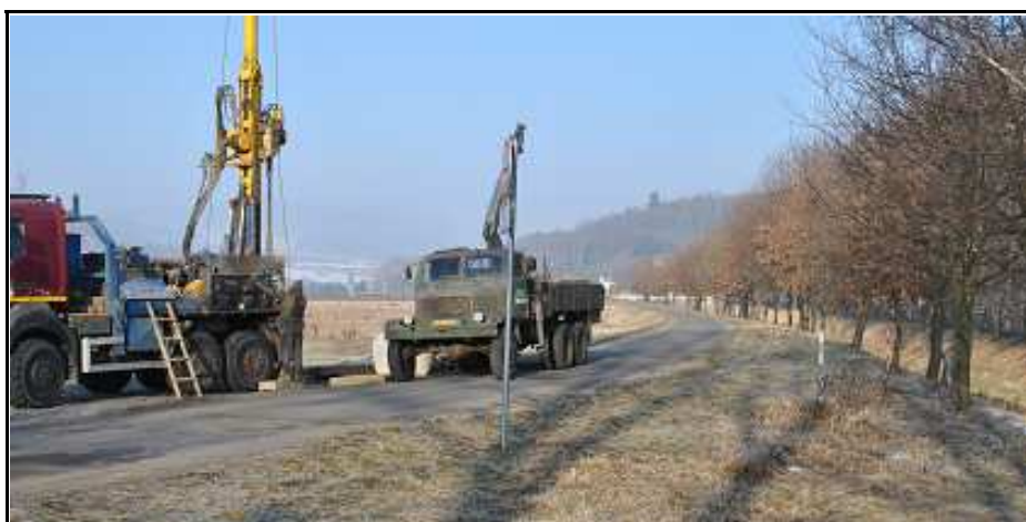
Obr.č. 8 : Pohled do prostoru hloubeného vrtu PJ 4 , situovaného do půdorysu levobřežní odlehčovací komory.
