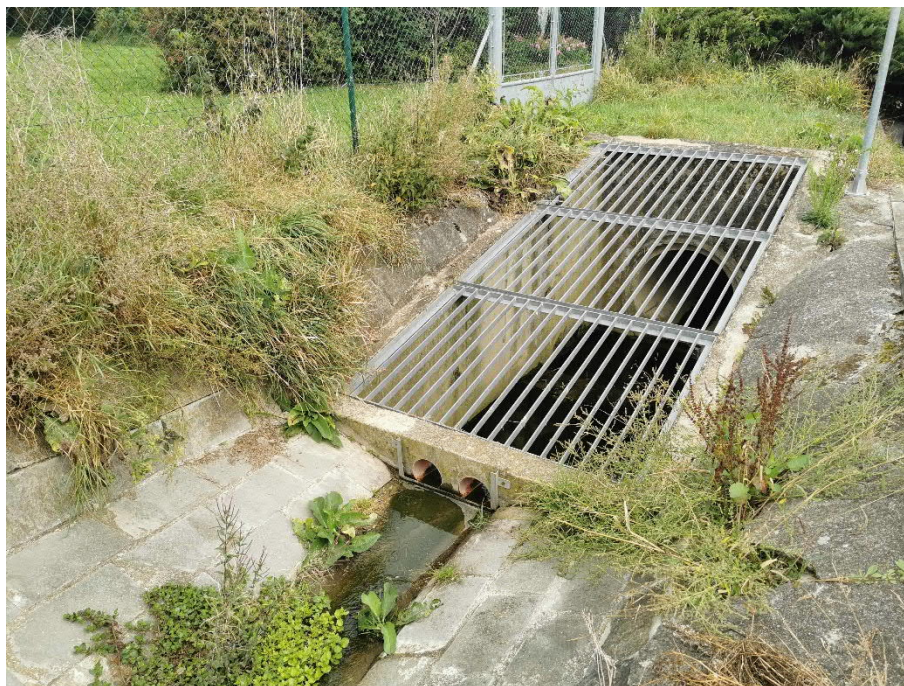
Obr. 1 – Opevněné koryto koncové části otevřeného koryta před zaústěním do DN 1000
